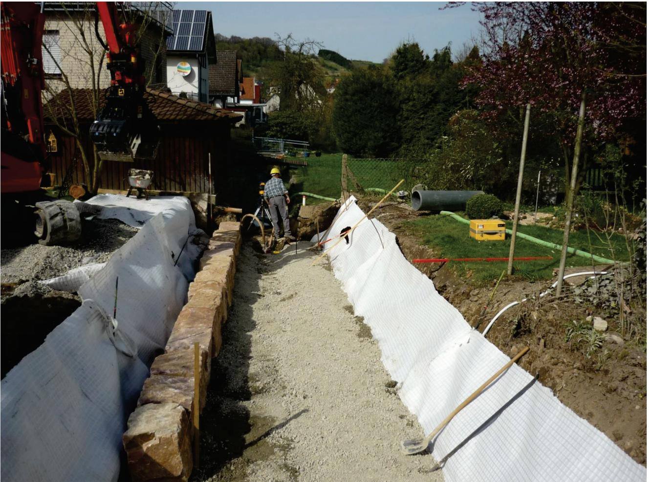
HQ 100-Ausbau Kuhlbornbach in Altenbeken, Sohlaufbau aus Geotextil und Schotter, einschl. Drainage
