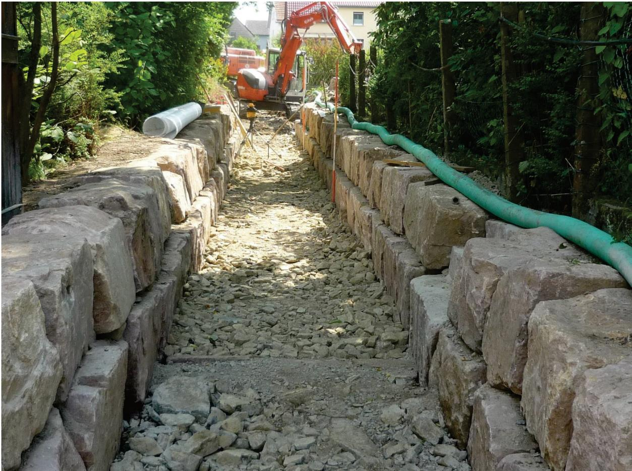
HQ 100-Ausbau Kuhlbornbach in Altenbeken, Setzen von Sandsteinblöcken zur Böschungssicherung
